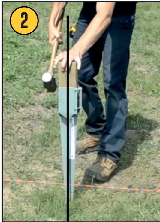
Le poteau doit être installé au niveau dans les 2 sens
